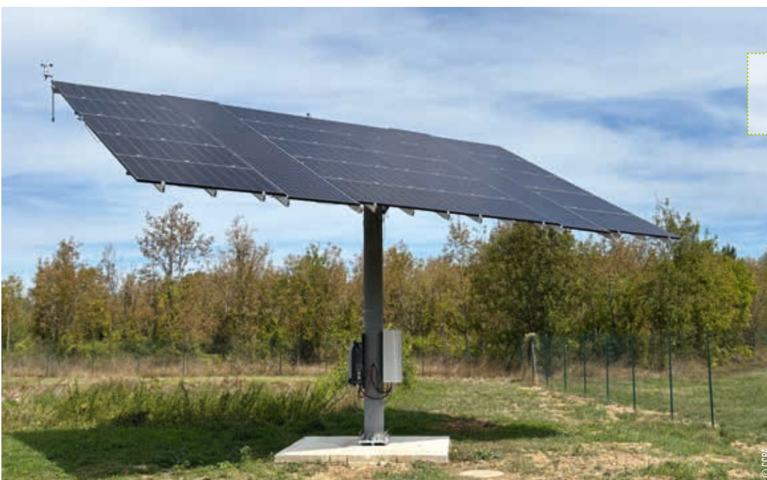
← Traqueur photovoltaïque sur la station d'épuration (STEP)
