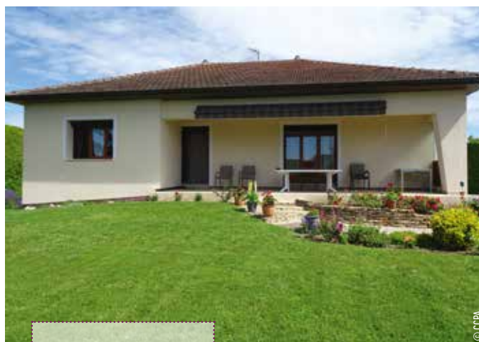
↑ Façade après travaux
