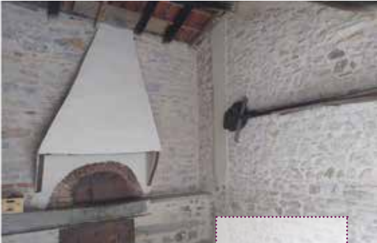
↑ Rénovation du four de Saint-Sorlin-en-Bugey
