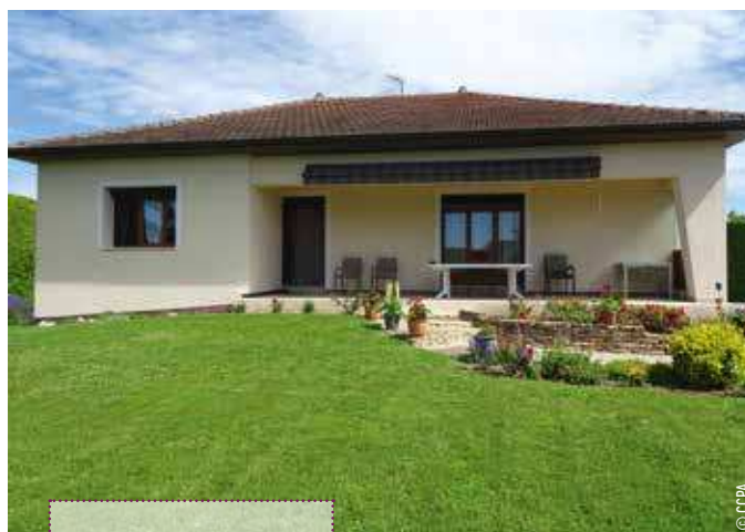
↑ Façade après travaux
