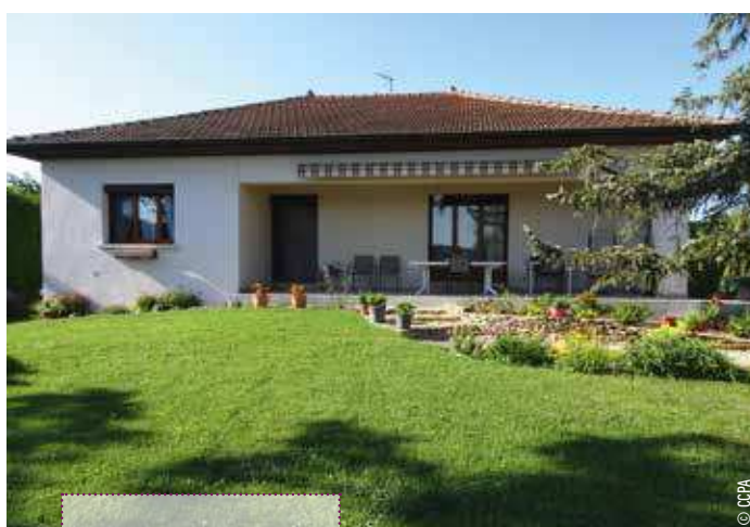
↑ Façade avant travaux
