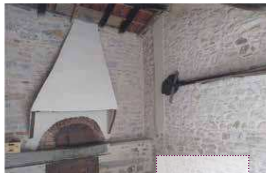
↑ Rénovation du four de Saint- Sorlin-en-Bugey
